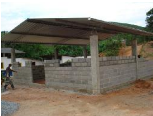
la Casa do artesão en construction en octobre 2007
